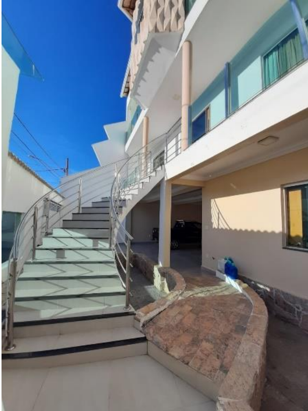
Figura 30: entrada casa construída na cidade de origem.
