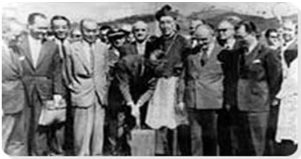
Presidente Juscelino Kubitschek (ao centro) crava a 1ª estaca da construção da Usiminas, em 1958
