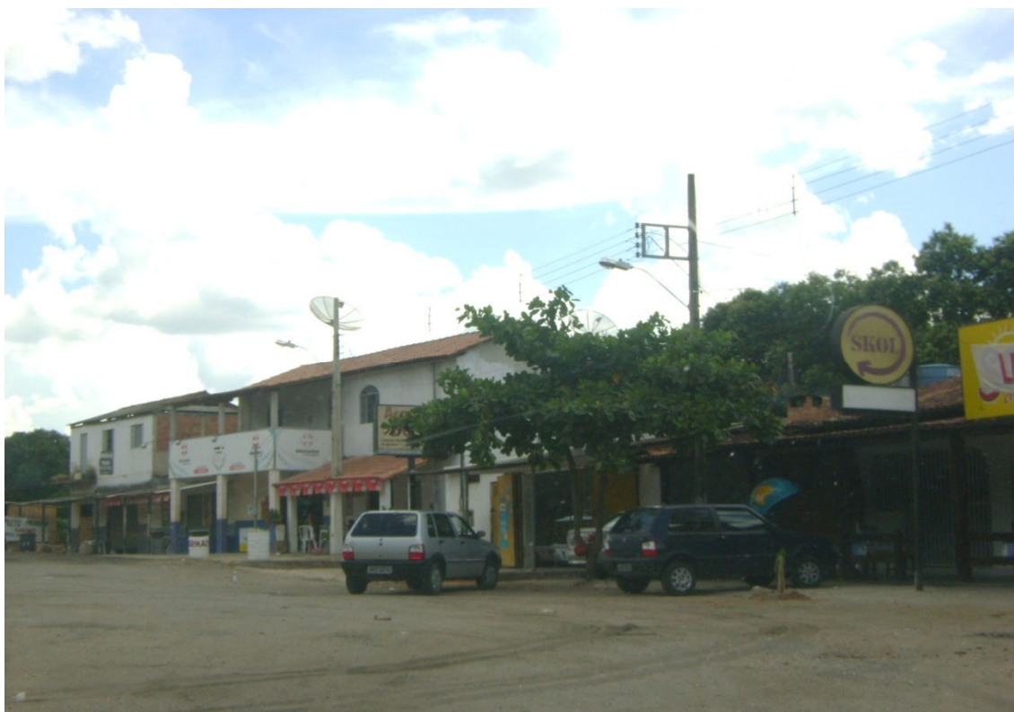
Figura 12: Centro comercial a esquerda da BR (sentido GV – TO), apresentando farmácia, restaurantes, barraca de coco. Fonte: Lopes, 2010.
