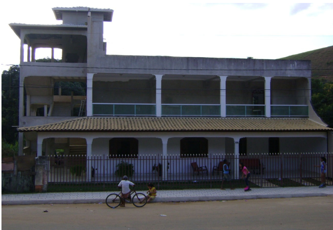
Figura 17: Casa grande, bem estruturada, do lado esquerdo da BR. Fonte: Lopes, 2010.
