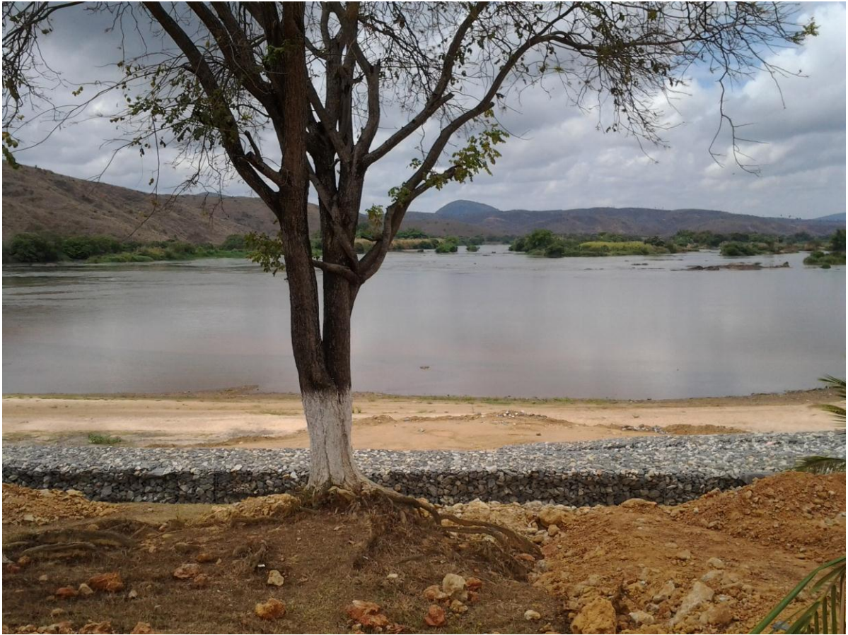
Foto 07 – Obra de revitalização da Prainha do Jaó - Agosto de 2011
