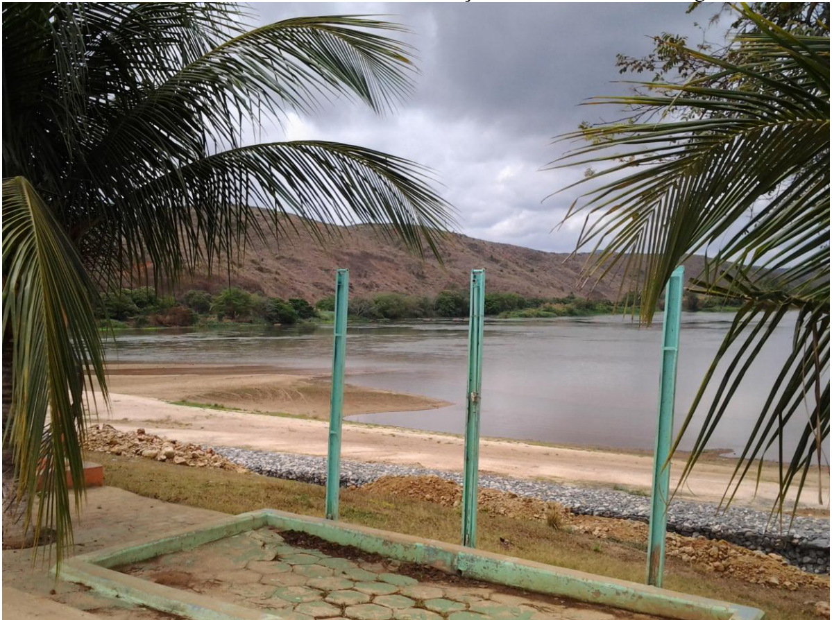
Foto 06 – Obra de revitalização da Prainha do Jaó - Agosto de 2011
