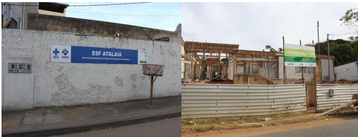
Figura 11 - Estratégia Saúde da Família (ESF) Atalaia. Obras de construção da UBS do bairro Jardim Atalaia, respectivamente.
