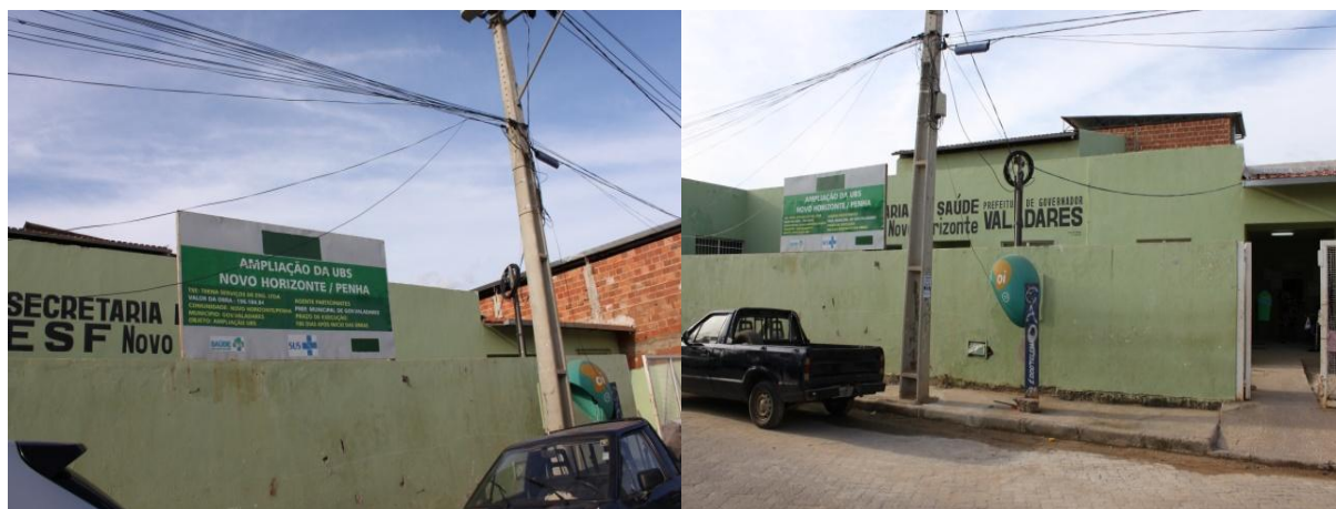
Figura 19 - Obras de ampliação da UBS do Novo Horizonte/Penha. Fonte: Fotos da autora (2015).
