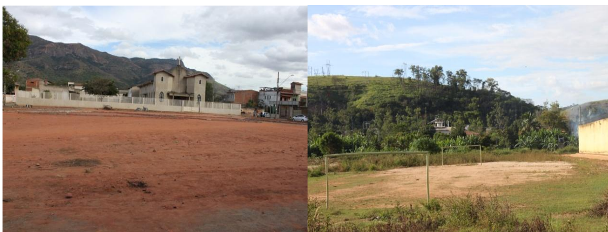
Figura 40 - Vista das obras de construção da praça (2015). Vista do campinho de terra ao lado do Centro de Intervenção.
