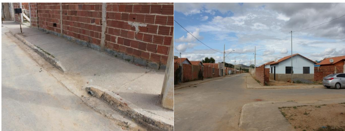
Figura 36 - Calçada adaptada para PNE. Acesso aos serviços de iluminação pública, energia elétrica e TV a cabo.
