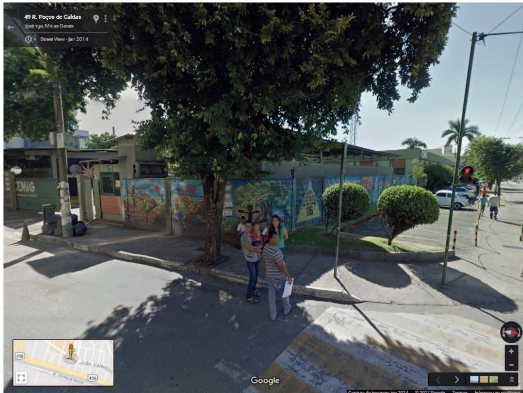
Figura 434 - Rua Poços de Caldas. Muro Cemig com grafite; Cruzamento Rua Poços de Caldas e Avenida João Valentim Pascoal
