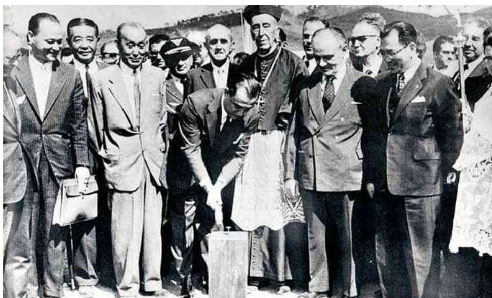
Figura 01 – Cravação da estaca de início da obra da Usiminas - 1958.
