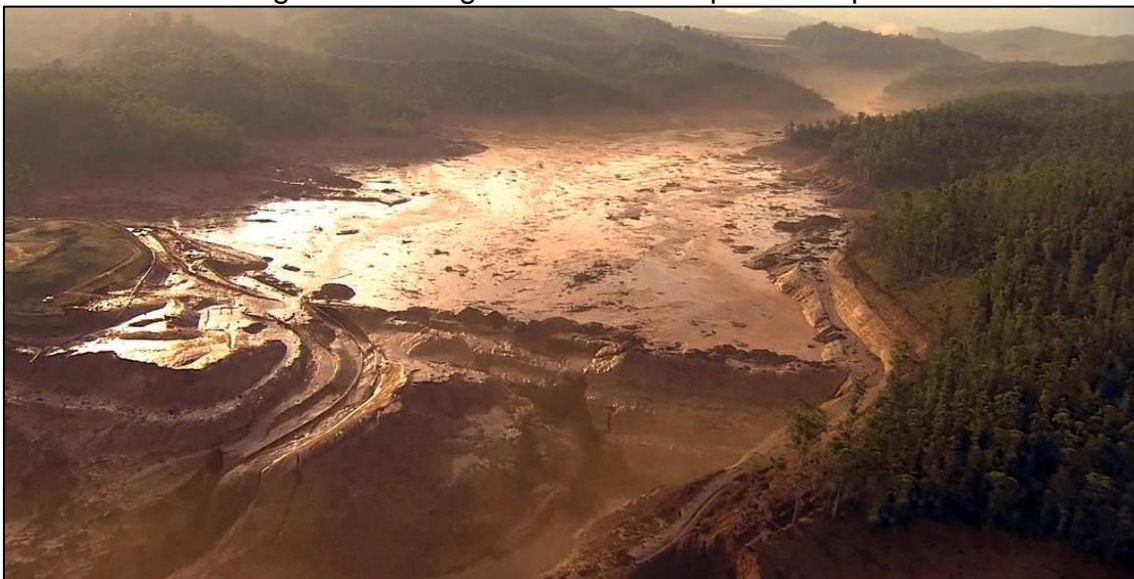
Figura 6: Barragem de Fundão após o rompimento
