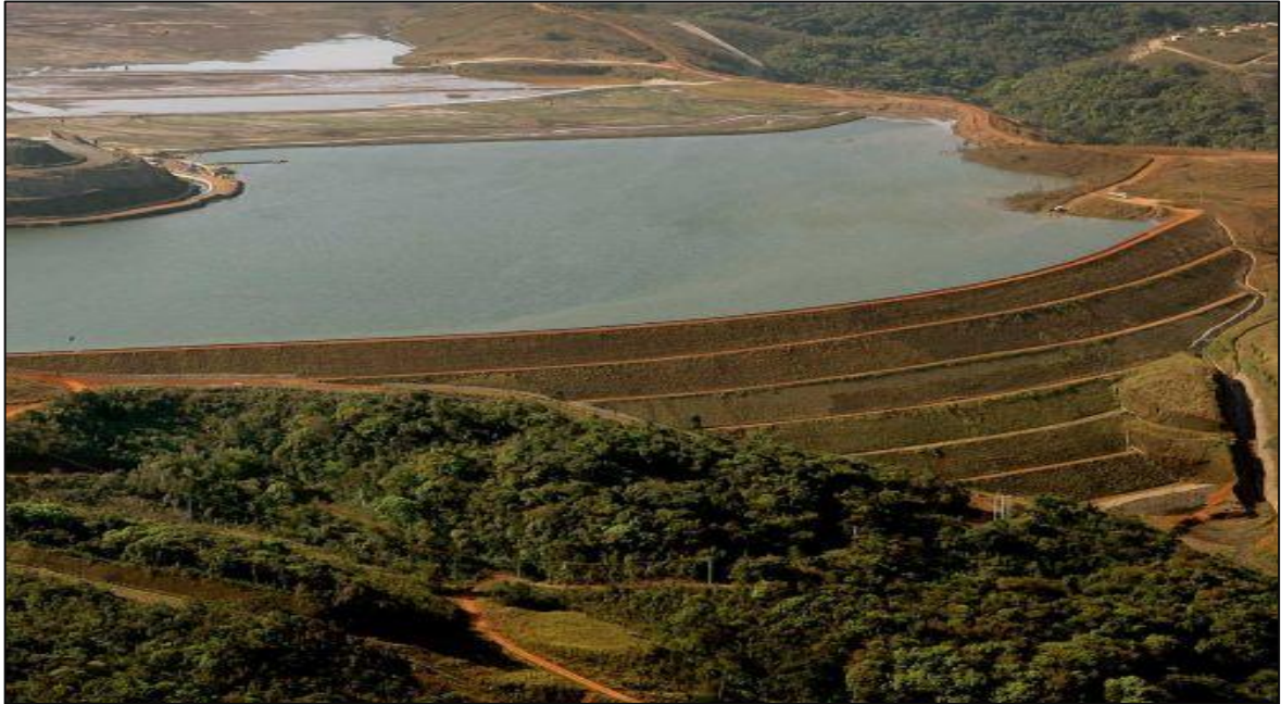
Figura 5: Exemplo de barragem de contenção de rejeitos com a técnica de alteamento.
