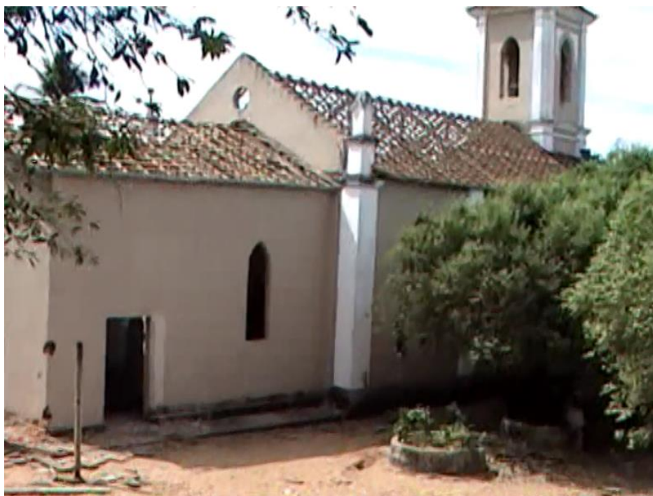
Figura 20– Registro externo da demolição da igreja
