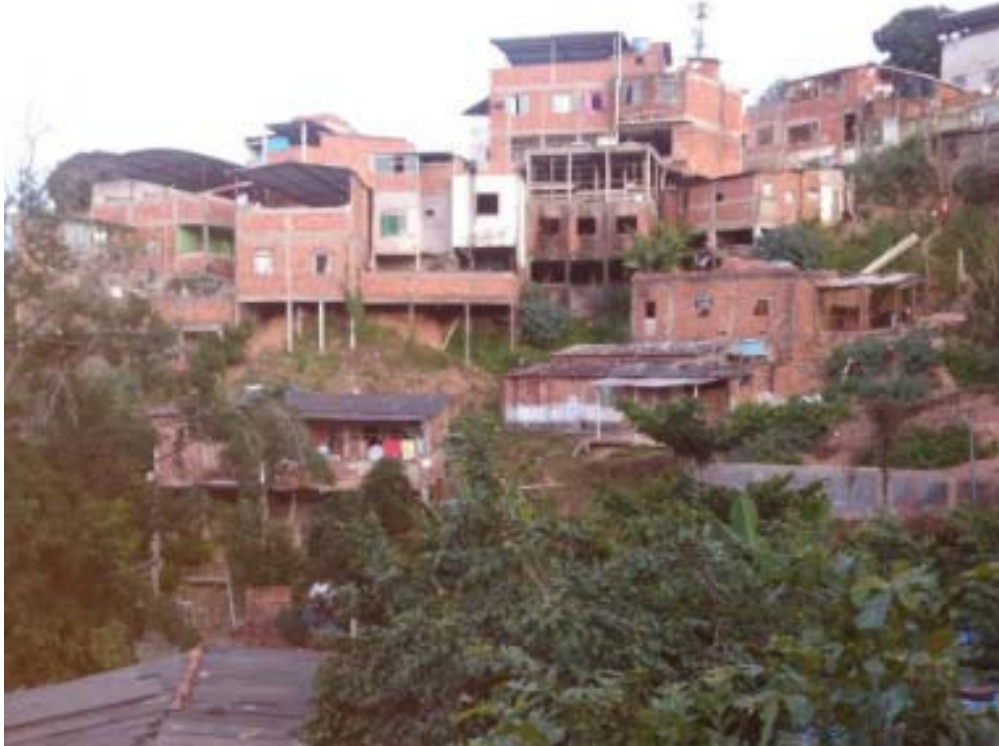
Figura 4 - Casas com risco de desmoronamento.
