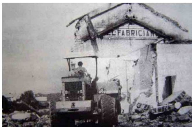
Figura 13 – Demolição da velha estação em 1982. Fonte: ACECIVA, 2020.
