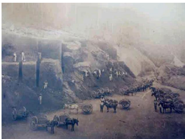
Figura 07 – Implantação de trecho da EFVM em Coronel Fabriciano/MG. Fonte: ACECIVA, 2020.
