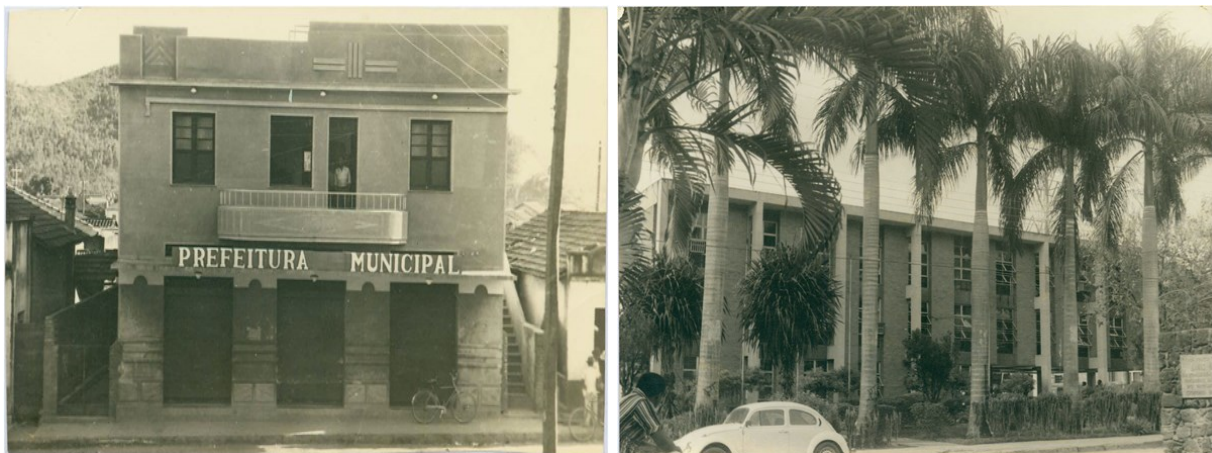
Figura 10 e 11 – Sede da Prefeitura Municipal de Coronel Fabriciano/MG.
