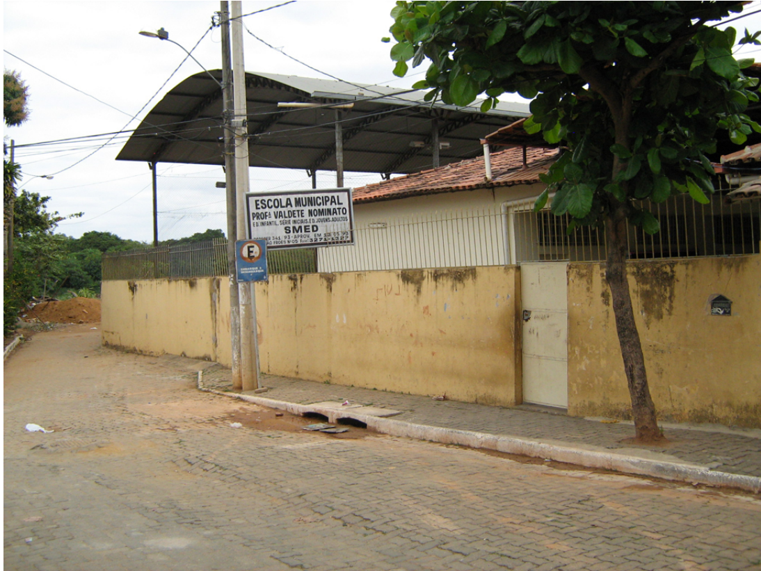
ANEXO A - Escola Valdete Nominato (Bairro São Tarcísio) Fonte: Foto de José Bispo Ferreira Filho
