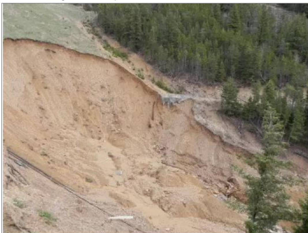
Figura 13 – Ruptura da Pilha de Estéril Alder Gulch
