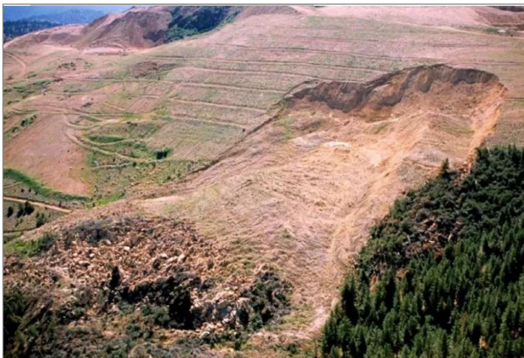
Figura 12 – Ruptura da Pilha de Estéril da Hayden Hill Gold Mine
