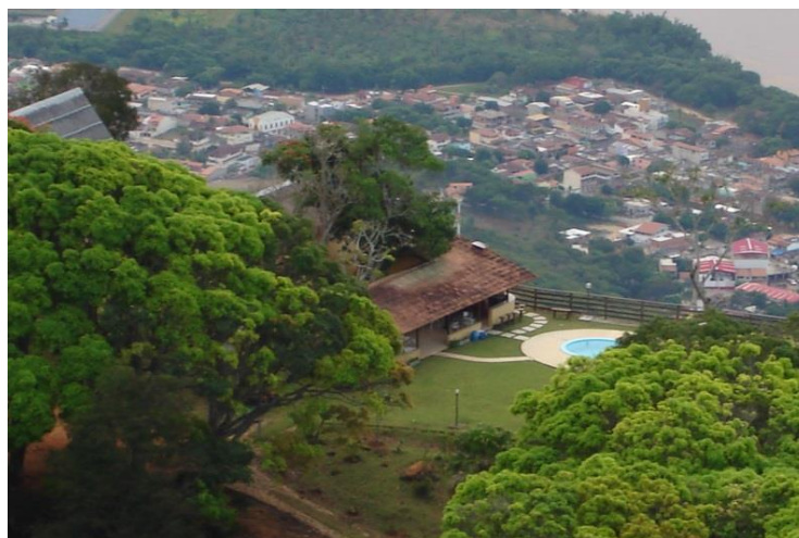
Figura 6 - Fotografia de construção na encosta norte do Pico da Ibituruna. Acervo Pessoal de SILVA FILHO, JBR – 11/03/2012
